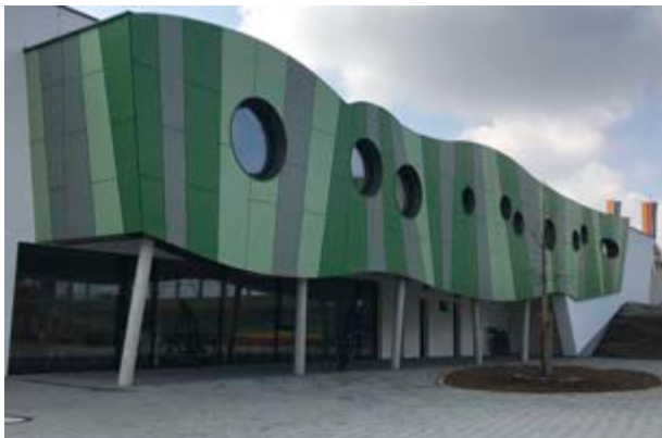
Die Kita St. Josef in Waibstadt hat eine VHF-Bekleidung genietet aus Trespa Meteor FR 8mm erhalten.
