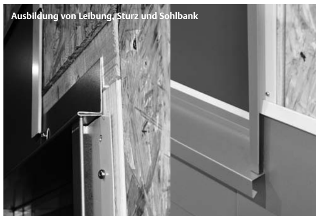
Ausbildung von Leibung, Sturz und Sohlbank u.a. erfolgt nach handwerklicher Technik.
